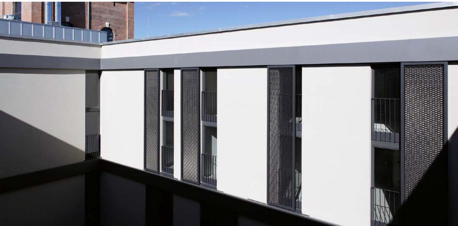
Les cadres MAX permettent d'utiliser des éléments d'ouvrants pouvant atteindre jusqu'à 5 m de hauteur, faciles à manier et coulissant sans bruit. Le large choix de panneaux (notamment les lamelles orientables et
